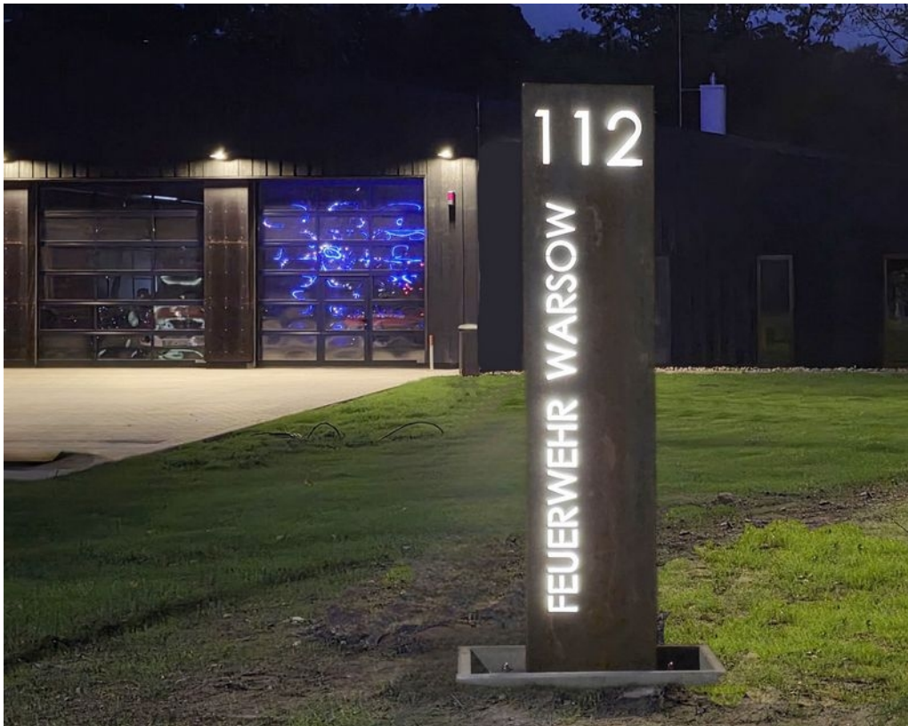
Neues Feuerwehrhaus bei Nacht
